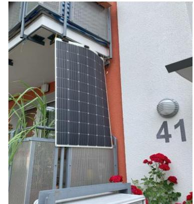
Balkonkraftwerke, hier ultraleichte versionen mit knapp 3 kg
